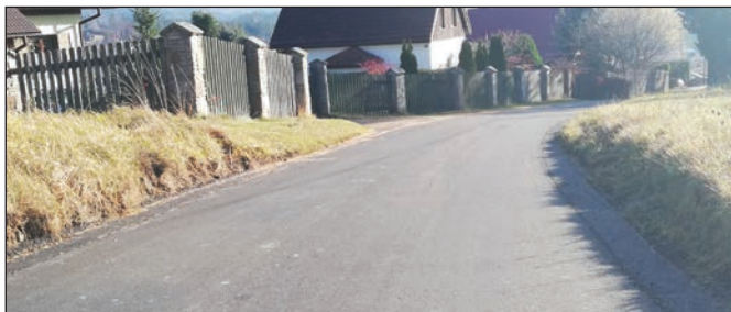
Nowa nawierzchnia drogi na Wilczym
