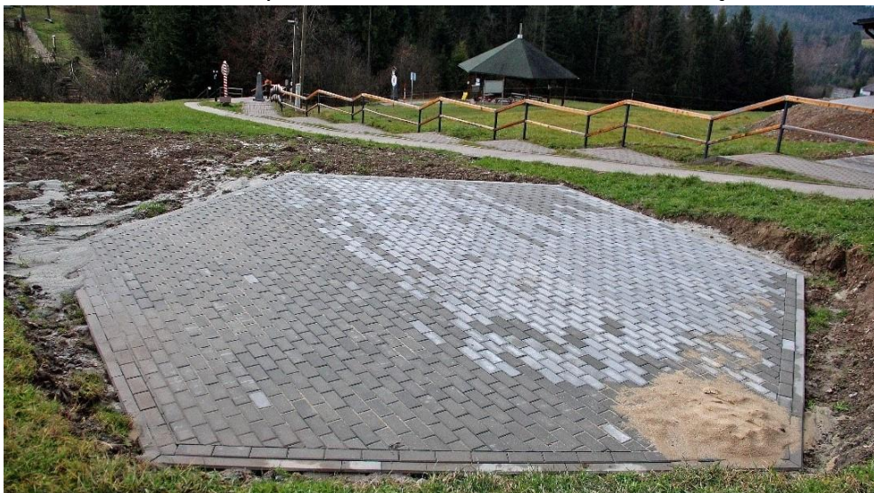
Zdjęcie: Budowa zaplecza piknikowego na Trójstyku
