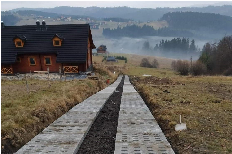
Zdjęcie: Przebudowa drogi pod Solisko w Jaworzynce
