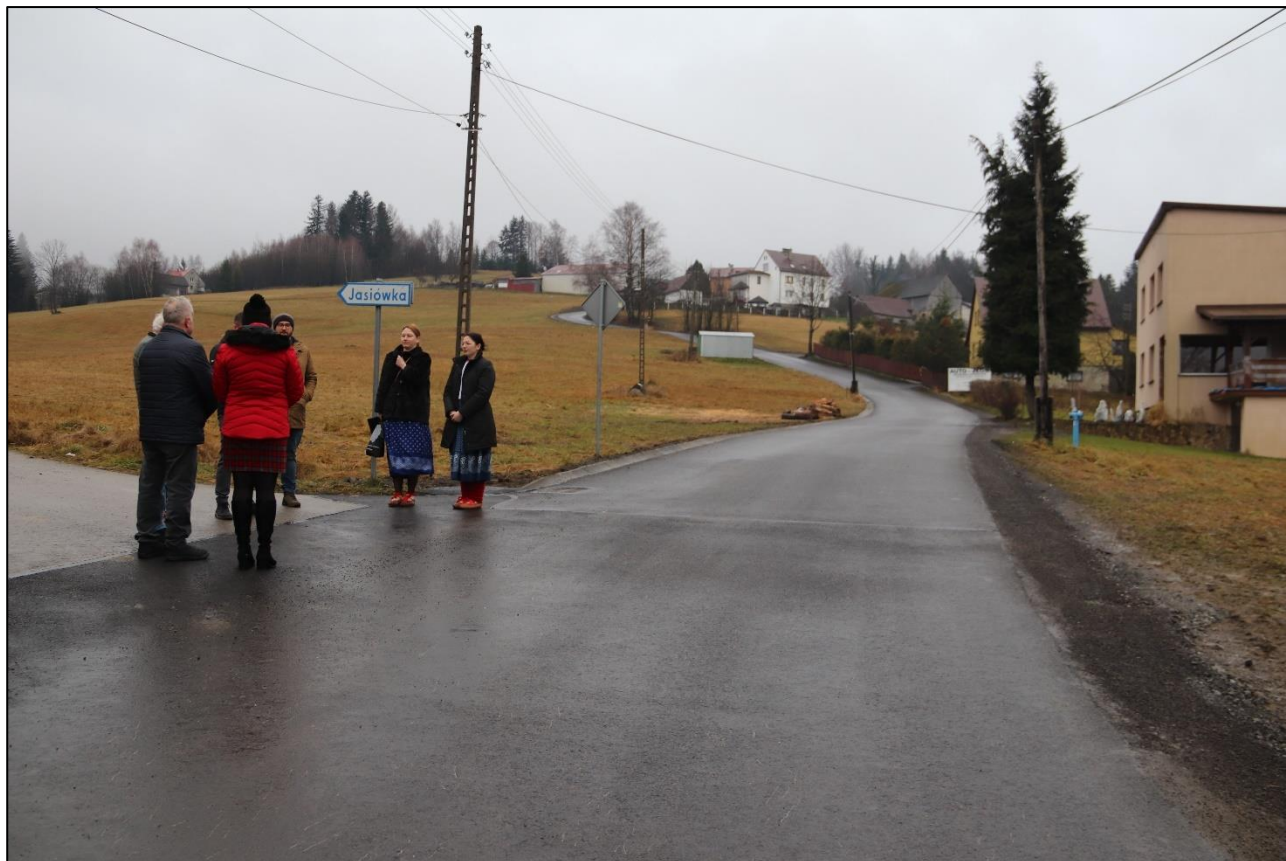
Fotografia 14.2.2 Zakończony remont drogi gminnej Dejówka-Pasieki w Koniakowie
