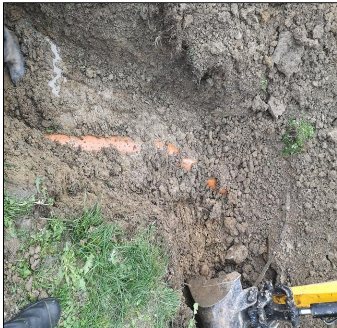
Fotografia 4.1.4 Z lewej: Zdjęcie awarii na sieci kanalizacyjnej w rejonie Jaworzynka Czepczory. Z prawej: Awaria na sieci kanalizacyjnej w rejonie Koniaków Odkrzasz.
