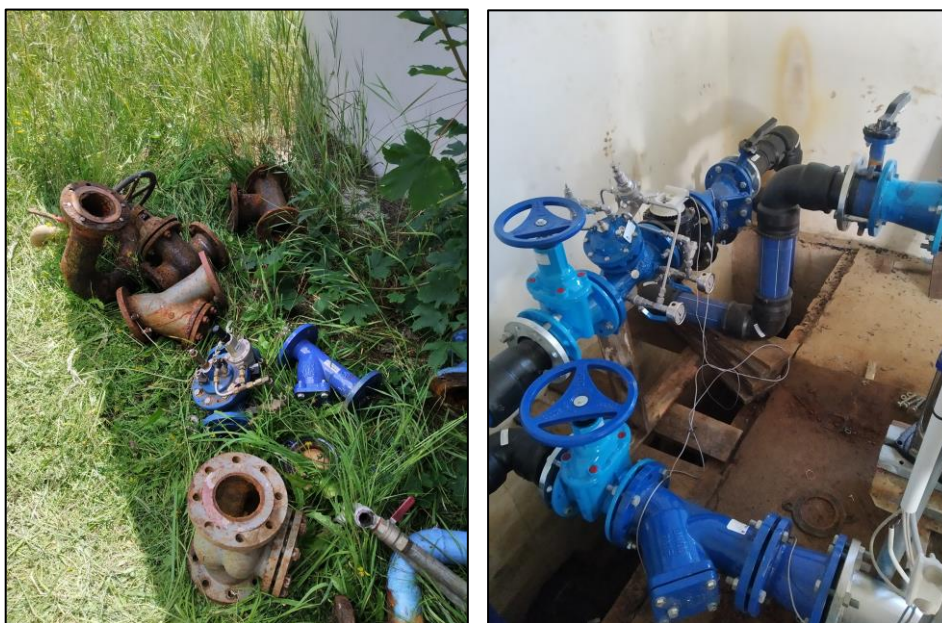
Fotografia 4.1.9 Z lewej: zdemontowana armatura wodociągowa z prawej: nowa zamontowana armatura wodociągowa na przepompowni
