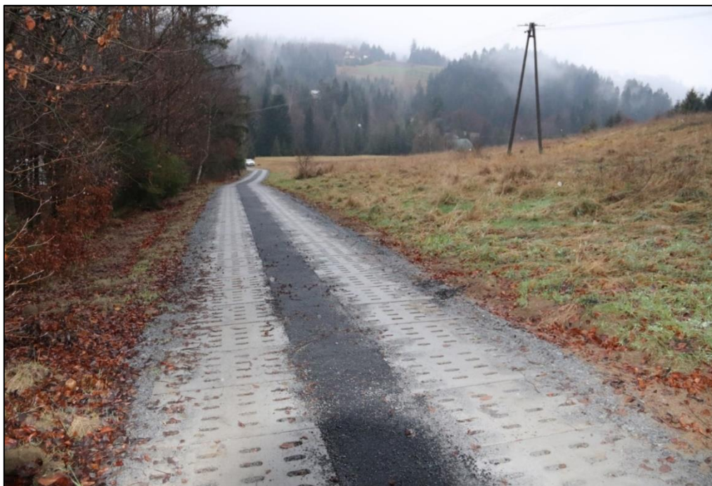
Fotografia 14.2.3 Remont drogi gminnej „Pod Siwe” we wsi Koniaków Remont drogi gminnej „Pod Solisko” w Jaworzynce
