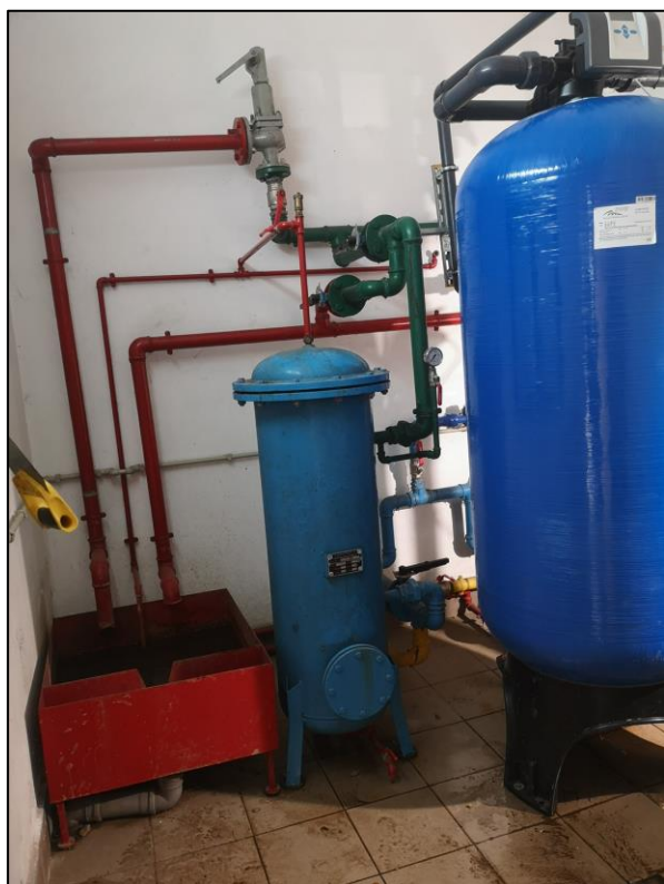
Fotografia 4.1.6 Z lewej: Stary filtr pośpieszny ze stacji uzdatniania wody Krężelka, z prawej: Nowy filtr pośpieszny zamontowany w stacji uzdatniania wody Jaworzynka Krężelka.
