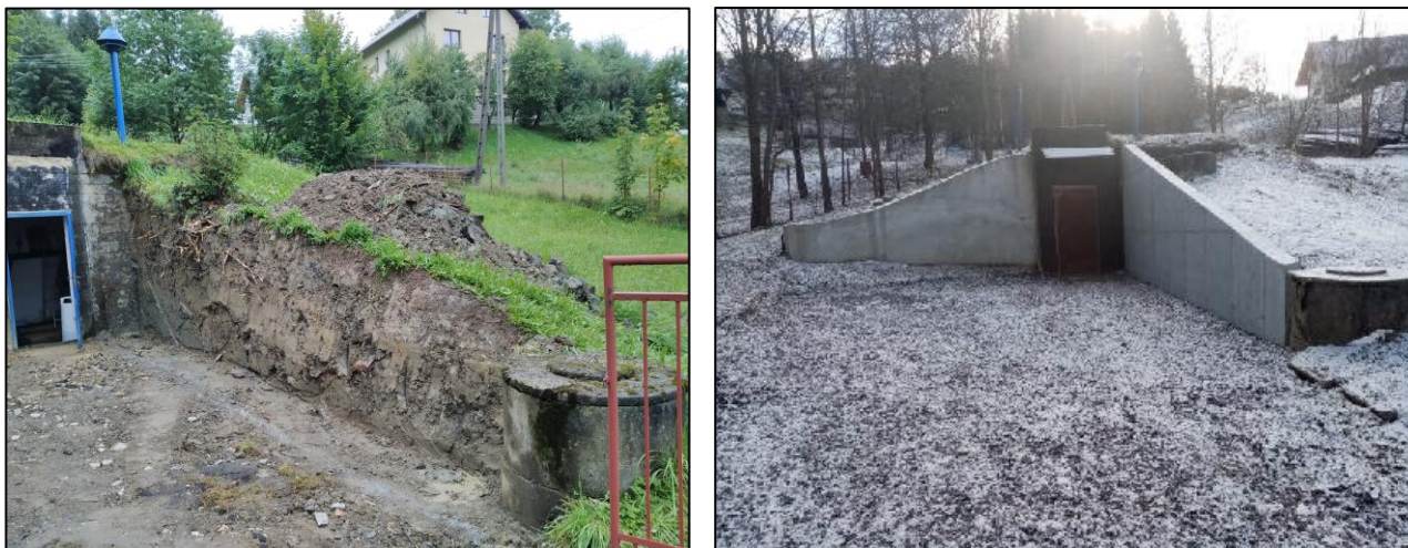
Fotografia 4.1.10 Z lewej: rozbiórka starego muru oporowego z prawej: w tle Suw Koniaków Bukowina z nowym murem oporowym.
