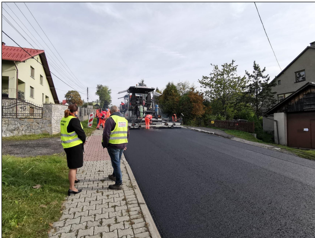
Fotografia 14.3.1 Remont nawierzchni DW 941
