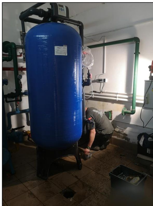
Fotografia 4.1.6 Z lewej: Stary filtr pośpieszny ze stacji uzdatniania wody Krężelka, z prawej: Nowy filtr pośpieszny zamontowany w stacji uzdatniania wody Jaworzynka Krężelka.
