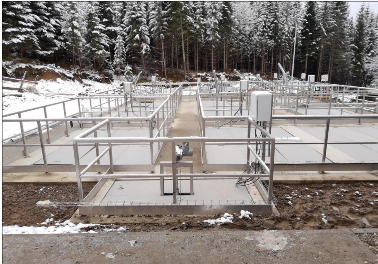
Fotografia 14.1.1 Przebudowana oczyszczalnia ścieków Pustki w Koniakowie
