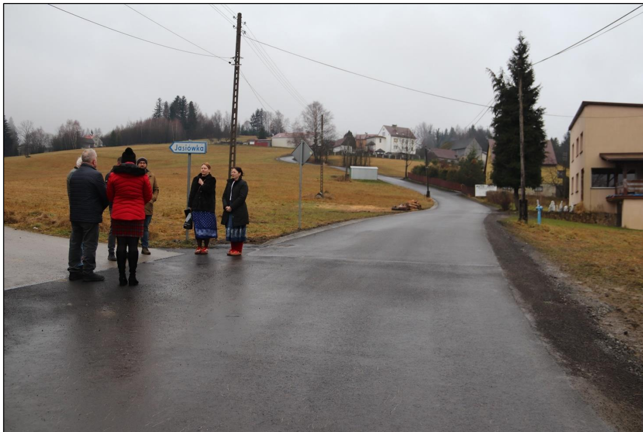
Fotografia 14.2.2 Zakończony remont drogi gminnej Dejówka-Pasieki w Koniakowie
