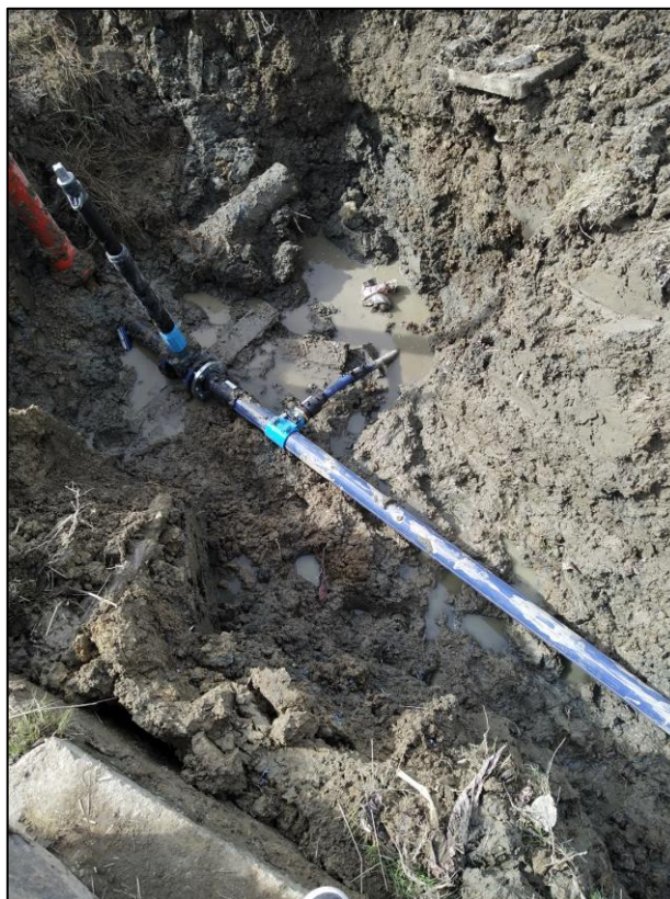
Fotografia 4.1.1 Prace nad wymianą awaryjnej sieci wodociągowej Koniaków Legiery DN 80 PE RC.
