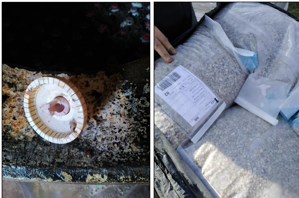
Fotografia 4.1.8 Z lewej: stara dysza filtracyjna, z prawej: nowe złożo do filtrów pośpiesznych
