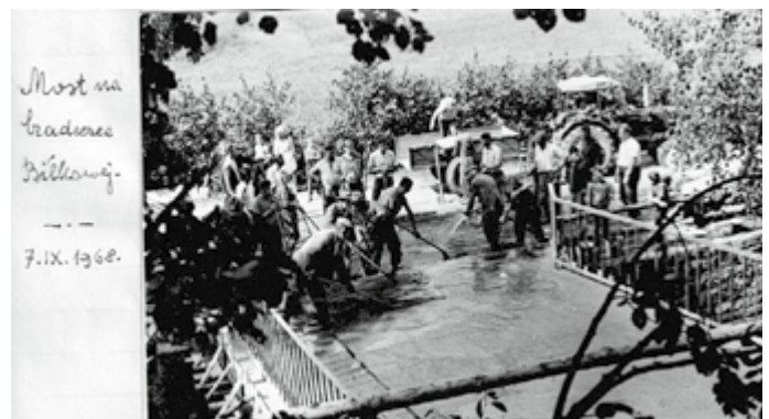
> Prace przy budowie mostu
