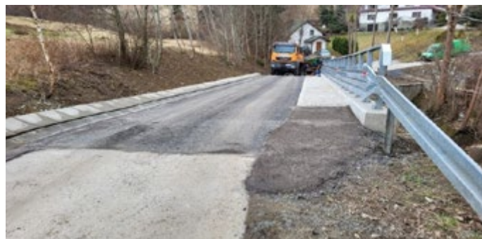
› Odbudowany mur oporowy na drodze gminnej Bryje II we wsi Istebna
