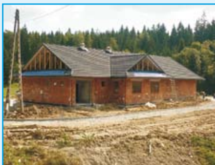
Budynek zaplecza sanitarno-technicznego
