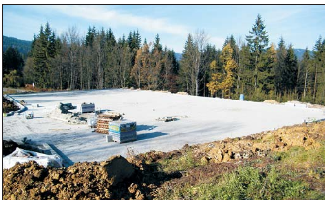
Budowa parkingu przy Ośrodku Edukacji Ekologicznej
