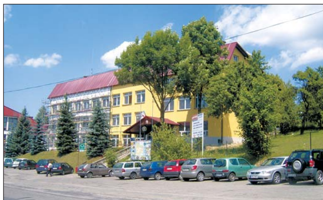
Termomodernizacja budynku Urzędu Gminy
