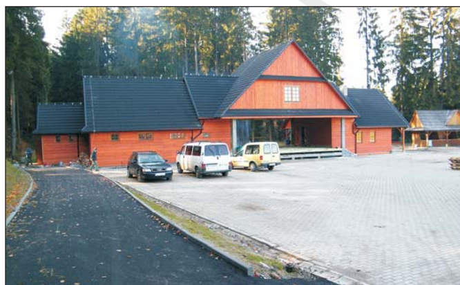
Przebudowa amfiteatru Pod Skoczną
