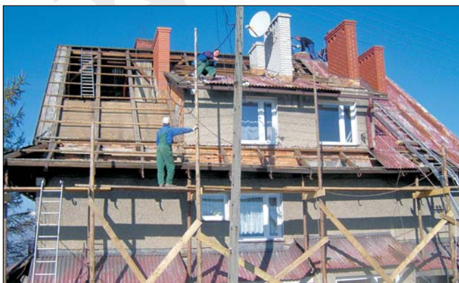
Remont pokrycia dachu Ośrodka Zdrowia w Jaworzynce - 2007
