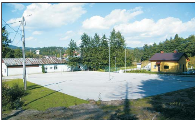
Budowa parkingu w rejonie amfiteatru
